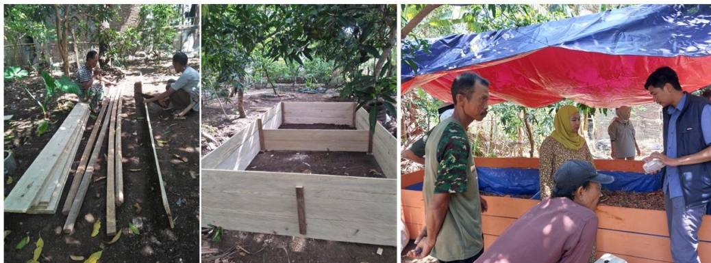
Gambar 4. Proses pembuatan tempat pengomposan.
