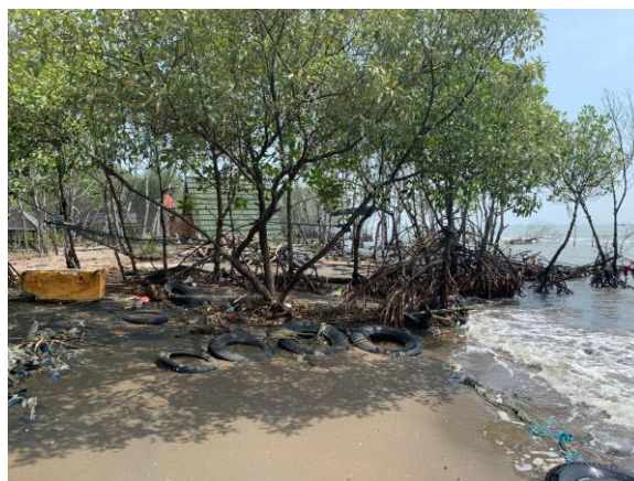
Gambar 4. Ban Tidak Efektif Memecah Ombak
