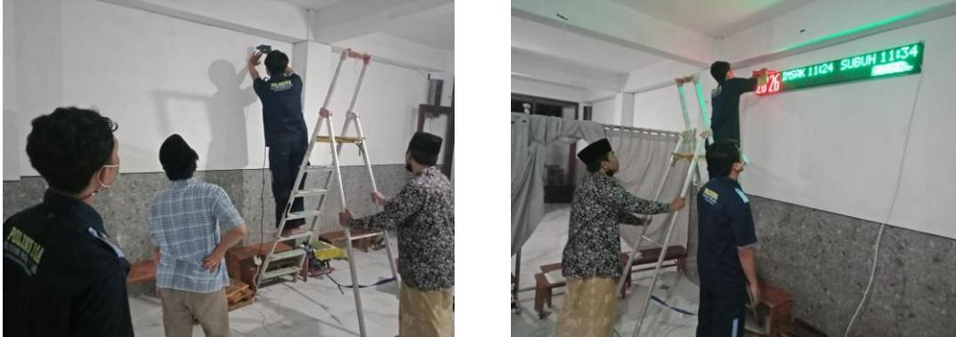
**Fig. 11.** Pemasangan *Running Text*
